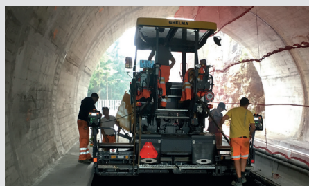
Instandsetzung Chienbergtunnel, Unterseen
