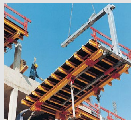
Umsetzgabel zur Umstellung auf das nächste Stockwerk
