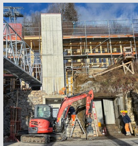
Bürogebäude mit Verbindungssteg
