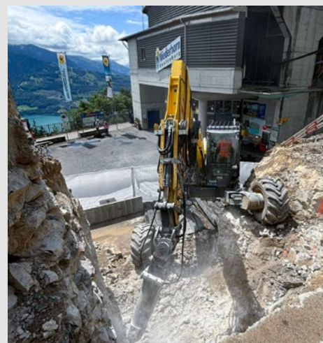
Felsausbruch für Liftschacht
