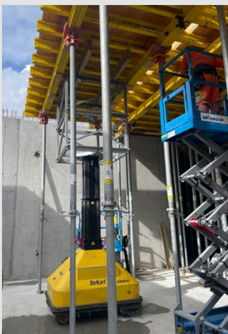
DoKart Plus mit zwei Aufstockelementen für Raumhöhen bis 5.36 m (UK Beton) im Einsatz
