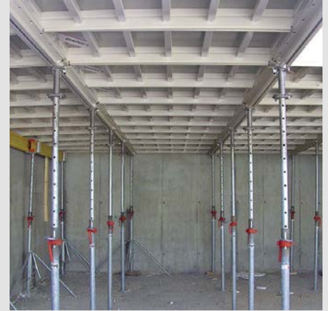
Variante Schalungssysteme Systeme im Betrieb: Peri SkyDeck/MevaDeck
