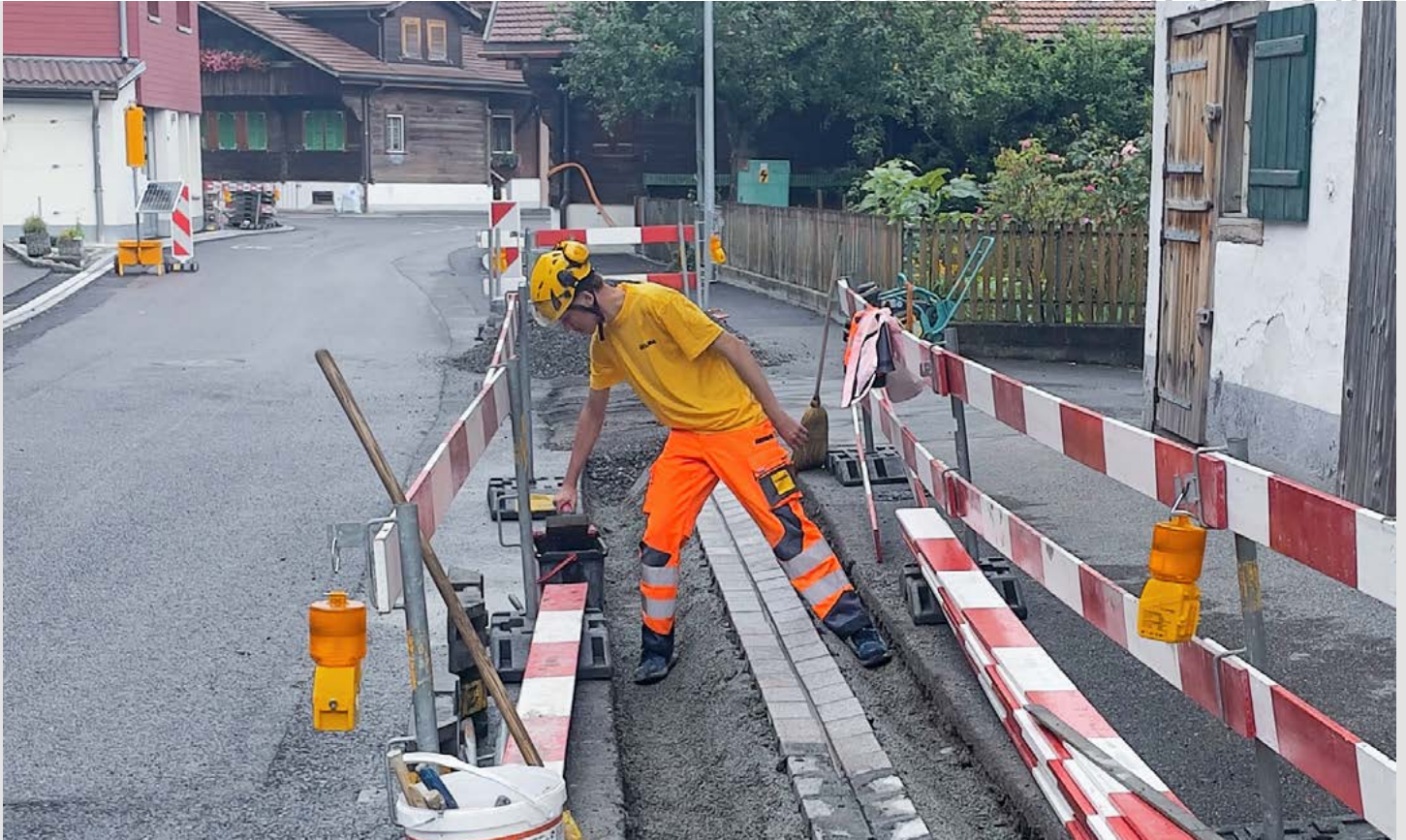
Mit voller Ghelma Montur ins Baustellen-Abenteuer
