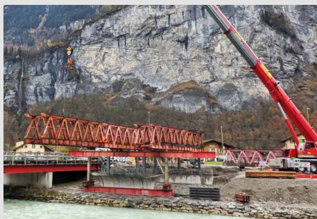
Montage des Lehrgerüsts
