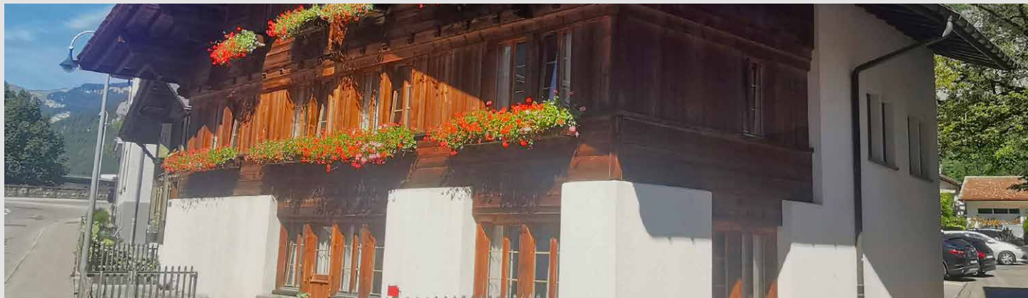
Aussenansicht der Liegenschaft an der Sandstrasse 3 in Meiringen
