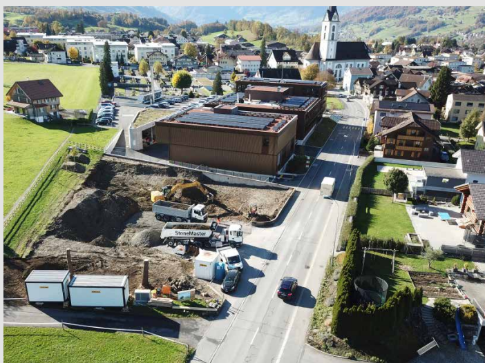
Start Aushubarbeiten Oktober 2023
