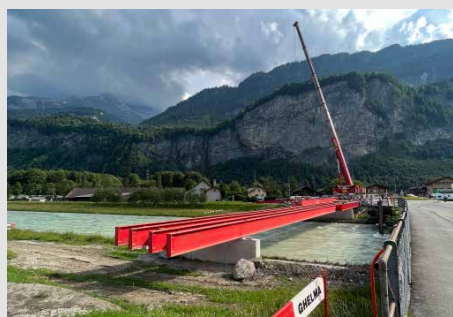
Montage der Hilfsbrücke
