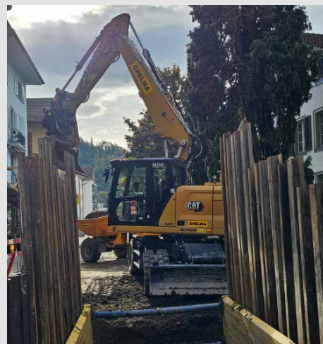
Einsatz in Interlaken bei engen Platzverhältnissen
