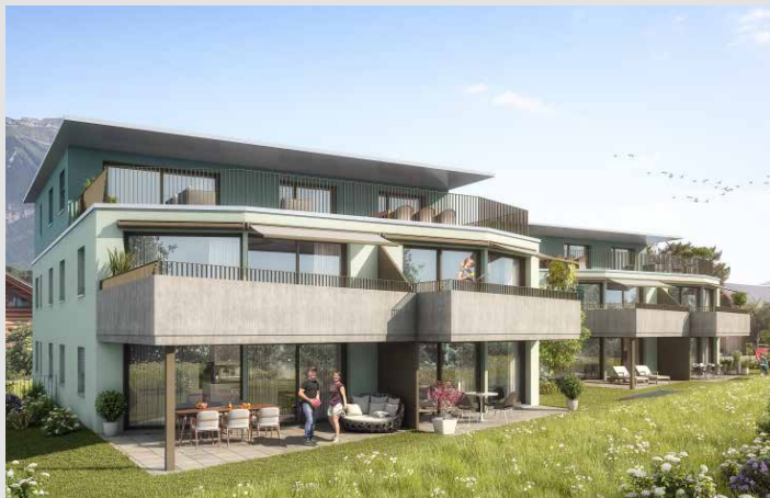
Südfassaden mit den grosszügigen Aussenbereichen
