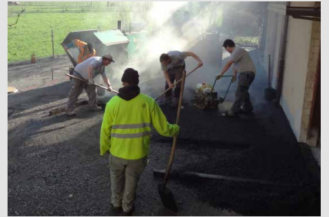
Belagsarbeiten Brugger, Wilderswil, 2012
