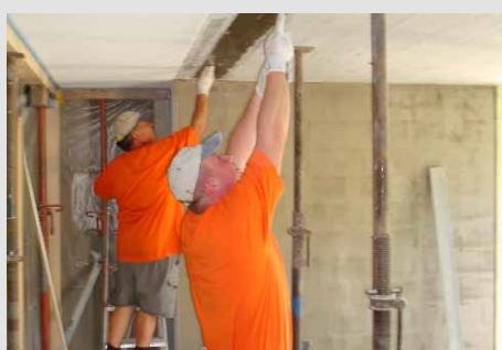
CFK Lamellen kleben, 2006
