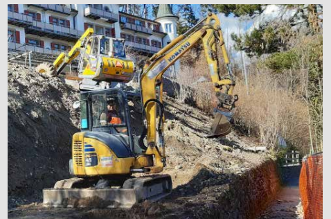
Stützmauer Sportplatz Schloss Unspunnen, 2019
