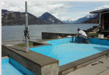
Sanierung Strandbad Leissigen, 2016
