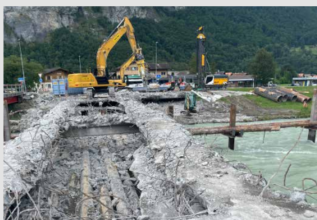
Abbruch der Brücke mit der Wasserhaltung
